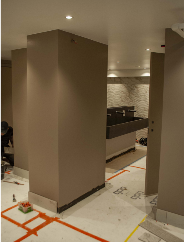
Vissa mellanväggar har sparats men med nya öppningar för att skapa ett öppet utrymme för de gemensamma toaletterna.
