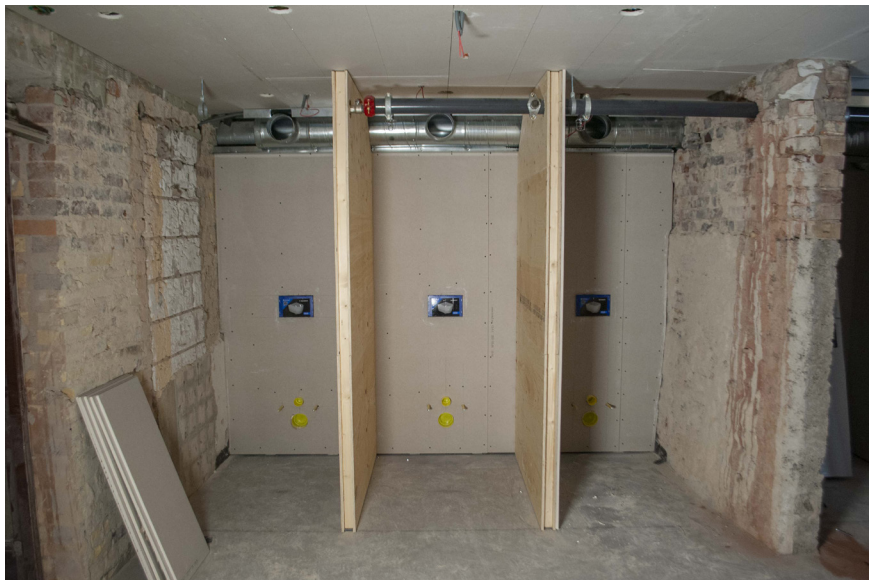
Några öppningar har gjorts i mellanväggar murade av tegel. Nya mellanväggar mellan toalettbasen har reglats upp och gipsats.
