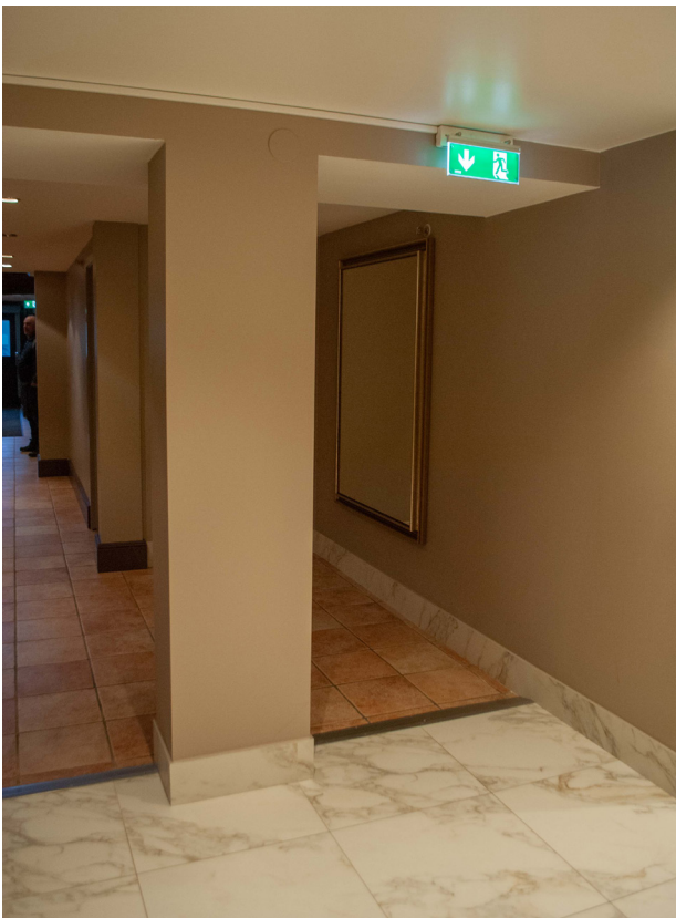
Vissa mellanväggar har sparats men med nya öppningar för att skapa ett öppet utrymme för de gemensamma toaletterna.
