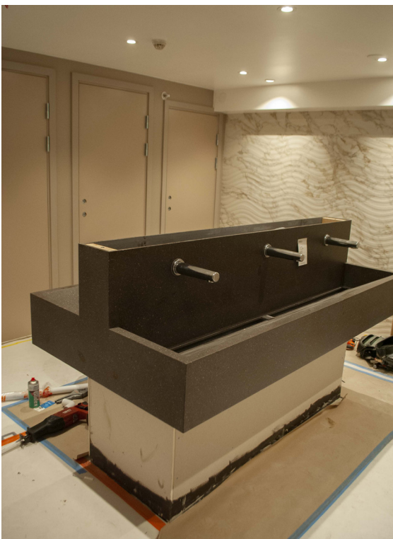
Väggen mellan de inre toaletterummen har tagits ned. I det öppna utrymmet har handfaten placerats. Fondvägen har försetts med kakel av vit marmor med vågmönster i relief.
