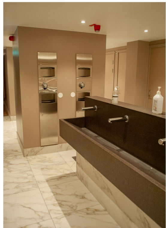
Väggen mellan de inre toaletterummen har tagits ned. I det öppna utrymmet har handfaten placerats. Fondvägen har försetts med kakel av vit marmor med vågmönster i relief.
