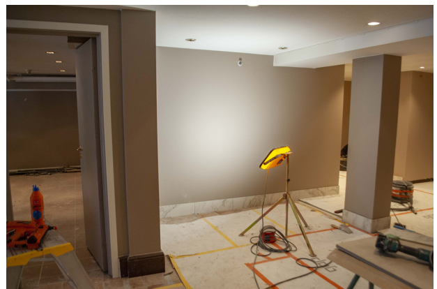
Mellanväggen mellan garderoben och foajén har flyttats så att det undanskymda utrymmet minskats.
