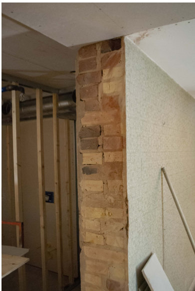
Några öppningar har gjorts i mellanväggar murade av tegel. Nya mellanväggar mellan toalettbasen har reglats upp och gipsats.
